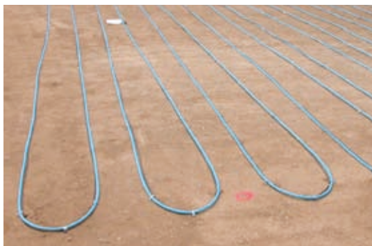
Installation des capteurs de mesure de température sous la plate-forme expérimentale.
