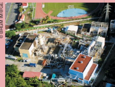
Bouillante, la première centrale géothermique française productrice d'électricité.
