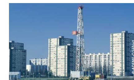
Forage géothermique à Bonneuil, Val de Marne, pour le chauffage d'un ensemble de logements collectifs
