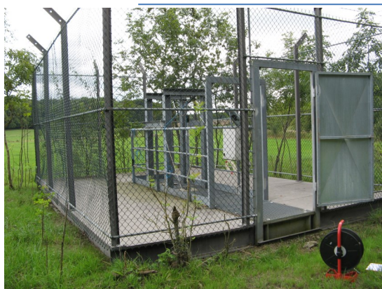
Puits Cheminée sud à Boulange (N5)
