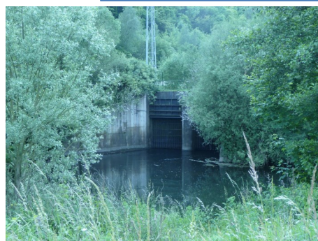
Déversement des eaux de la galerie du chenal de Moyeuve dans l'Orne (S4)
