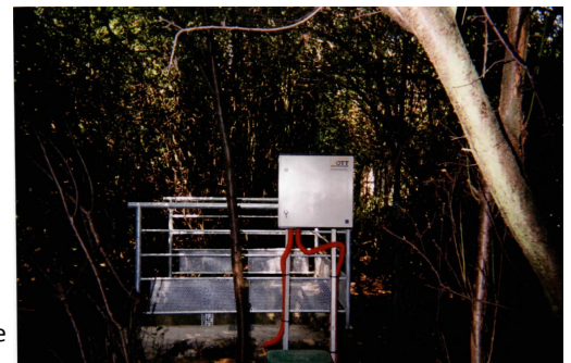
Exutoire de la galerie du Woigot à Mancieulles (C5)
