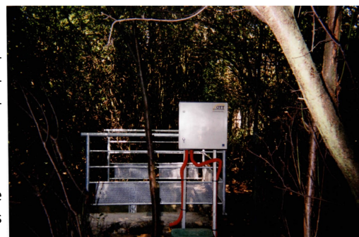
Exutoire de la galerie du Woigot à Mancieulles (C5)
